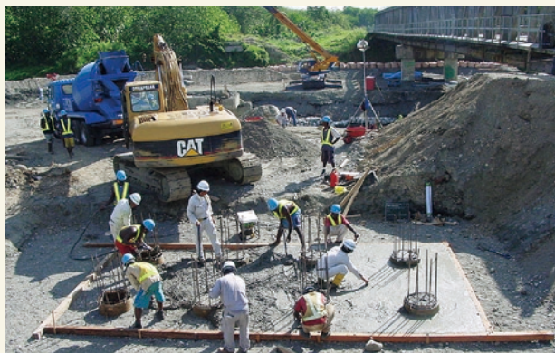
基礎工事を行う作業員(写真提供：中野さん)
