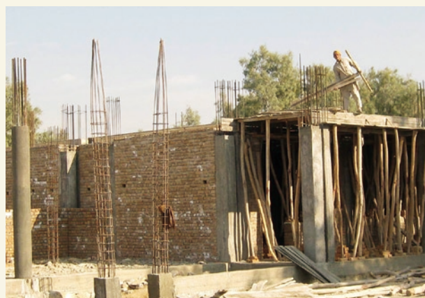
建設中のエマール・ババ高校(写真提供：UNDP)
