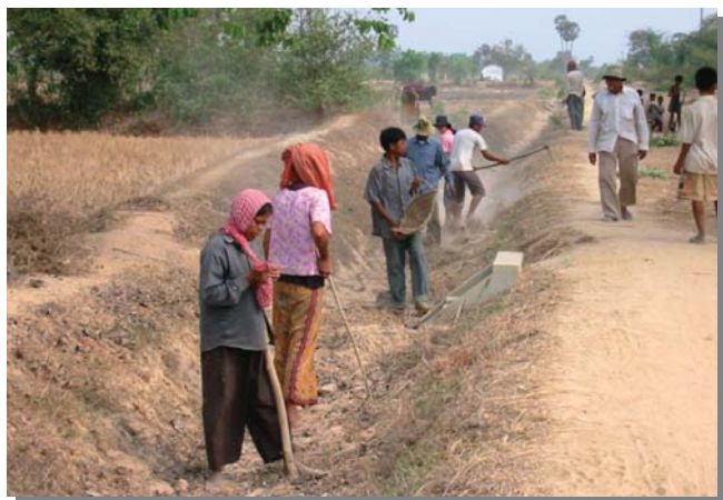
農民による用水路の建設
