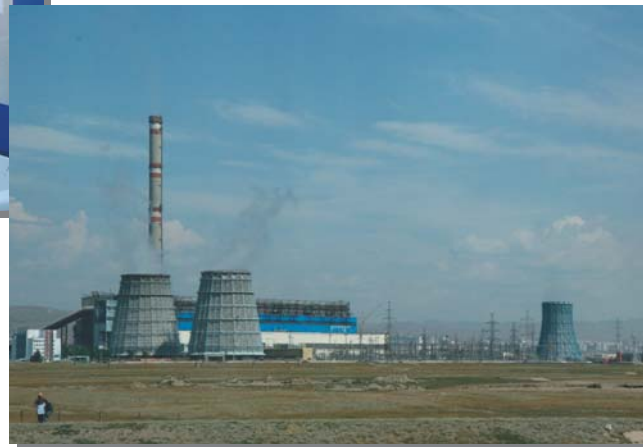
ウランバートル第4火力発電所
