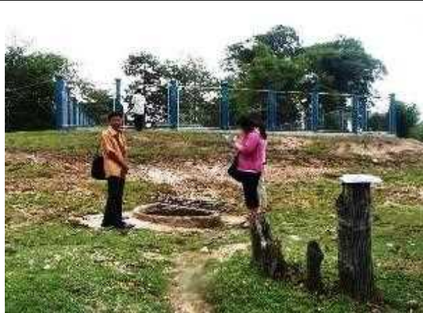
③地下型貯水槽と元水源(手前浅井戸)の位置関係 貯水槽上辺が元水源の土地高より約 3m 高い
