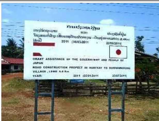
⑨看板 ウムナムコーン村側
