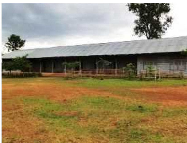
⑨2010年に政府予算で建設した校舎 壁は木造で屋根はトタンを使用している
