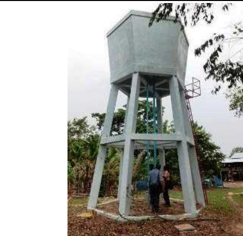
⑤高置水槽 破損しておらず、状態は良い
