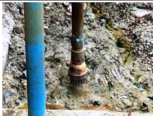
②地下型貯水槽取水口 取水口の高さには既に水が届いていない
