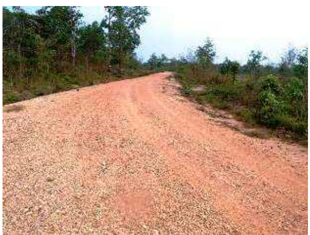
⑪事業地から 10km 程度離れた所にある土舗装道路 砂利の割合が多く、表面が均一の状態を保っている
