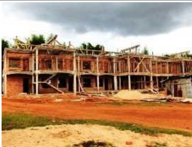
⑪政府予算で建設中の2階建て新校舎
