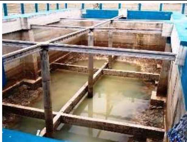
①地下型貯水槽 底部の水位が 20cm 程度
