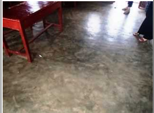
⑩2010年に政府予算で建設した校舎の床 床表面が滑らかで破損していない
