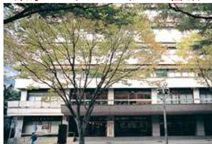
東京エレクトロンホール宮城
