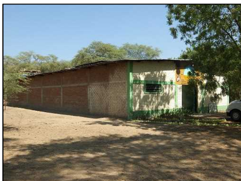
既存施設外観
