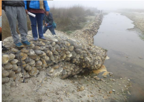
(下) ネパール・タライ平原のリュー川に 村人が設置したが、崩れ始めた蛇籠
