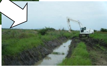
トンピン地区内排水溝整備
