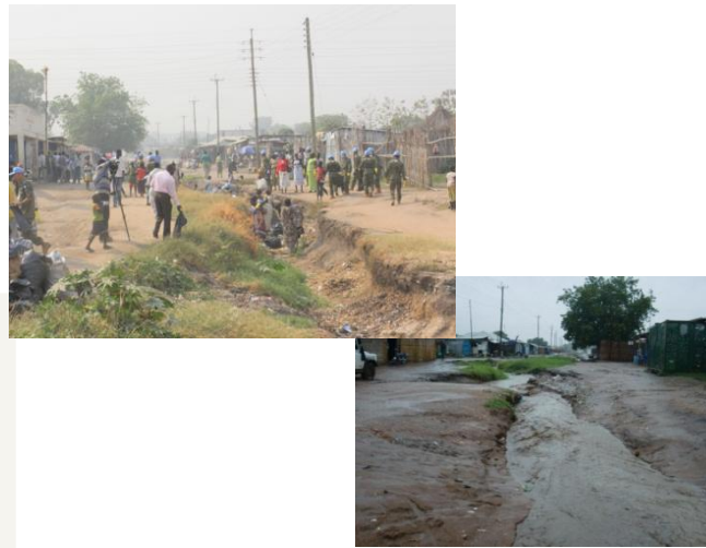
路面浸食の状況(左)と、降雨時の冠水状況(右)。
