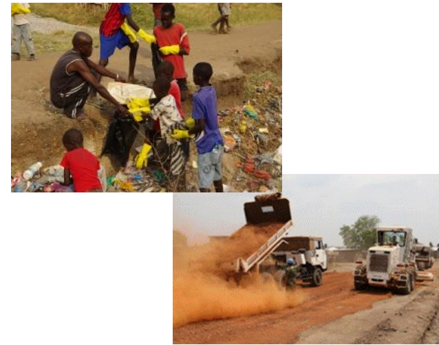
活動地域における地元住民との清掃作業(左)と、道路整備作業の様子(右)。
