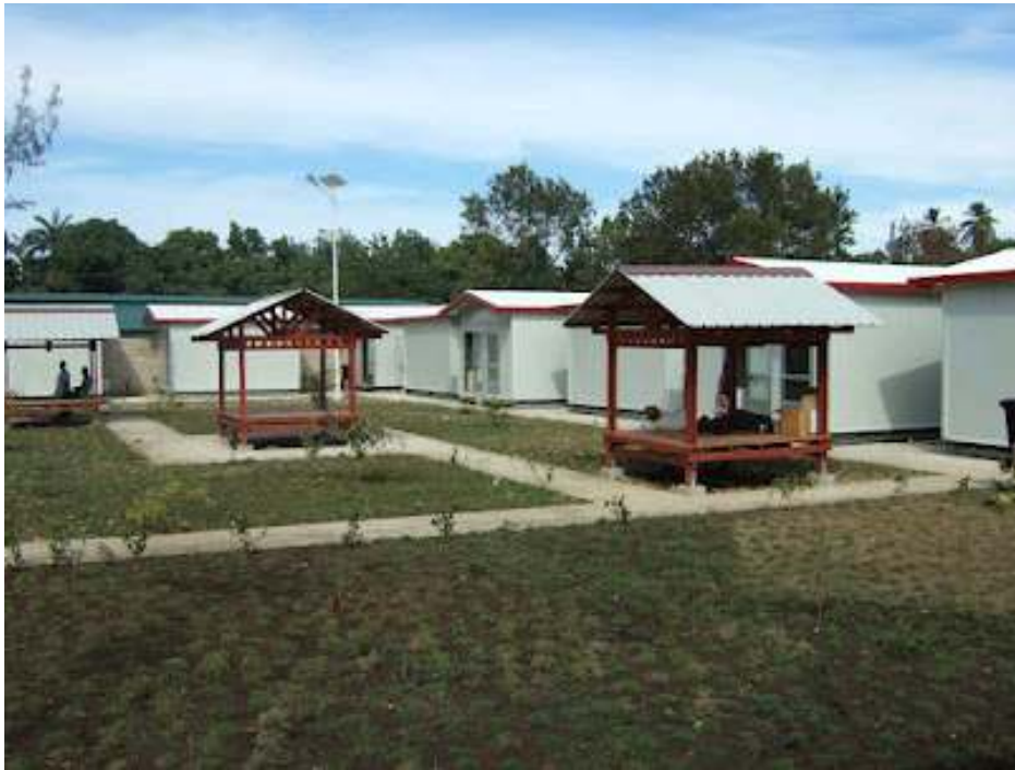
スイス赤十字社の寄付により、2011年12月後半シグノー結核療養所に仮設病棟が完成した。仮設病棟は3人部屋、プライバシーと衛生が保たれ、患者たちは大変喜んでいた
