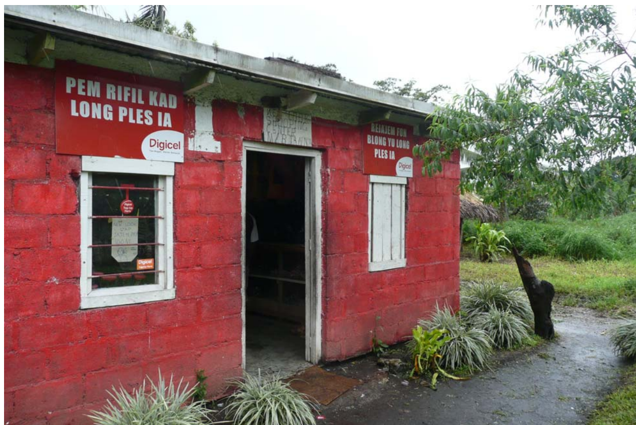
RTCの近隣にある店舗。建設にはRTCの建設分野の研修生も参加
