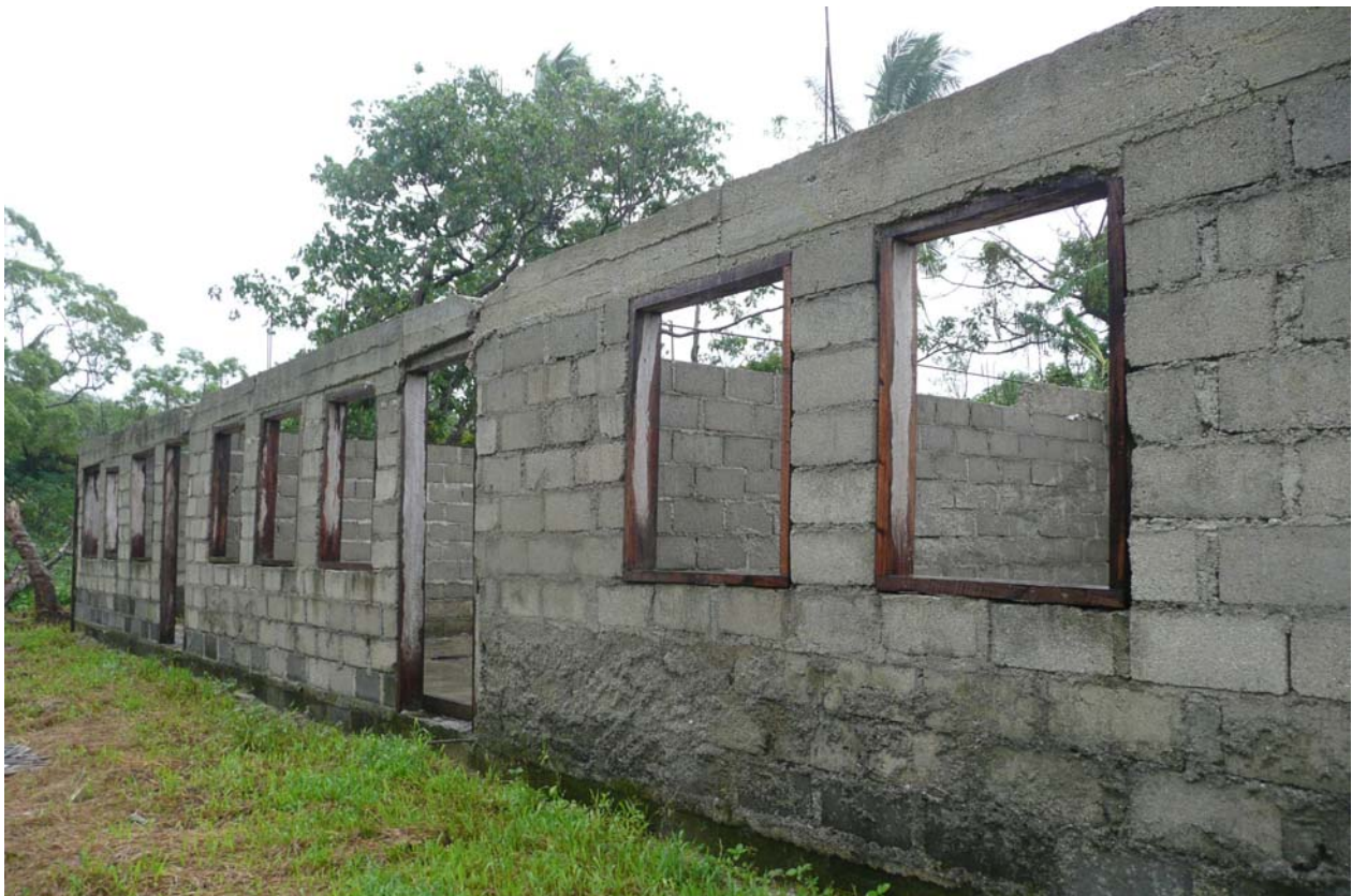
建設途中の新校舎
