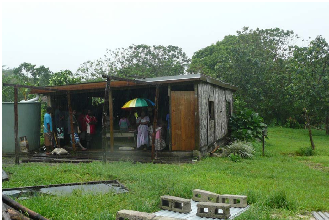
バヌアツ、タンナ島、ルメ村のトレーニングセンター(RTC)の現在の教室。サイクロンの被害を受け、雨漏りしている。
