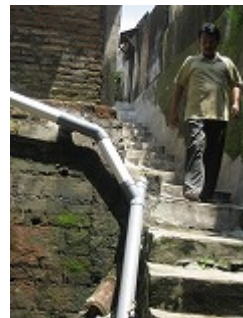
排水管が敷設されたコミュニティ 弊社撮影
