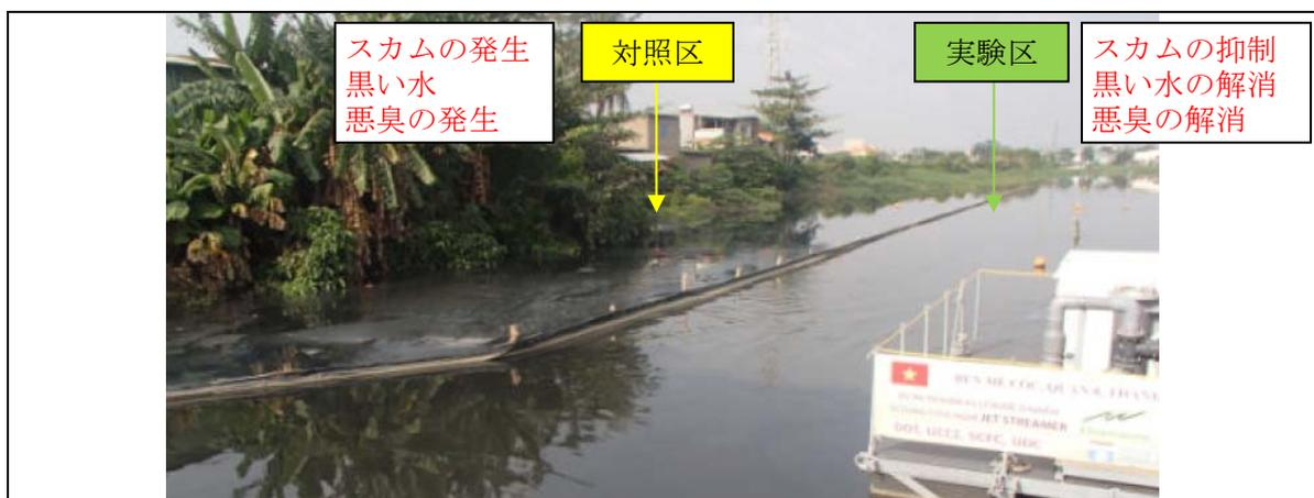
図3 水流発生装置「ジェット・ストリーマー」の設置効果
