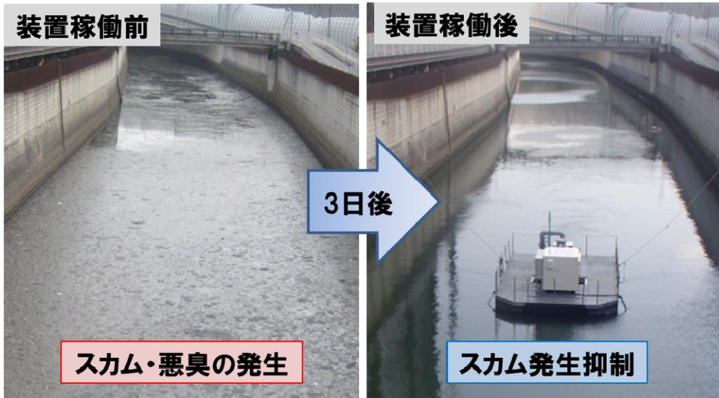
図 2.8 石神井川（東京都北区）の水流発生装置稼働前後の写真
