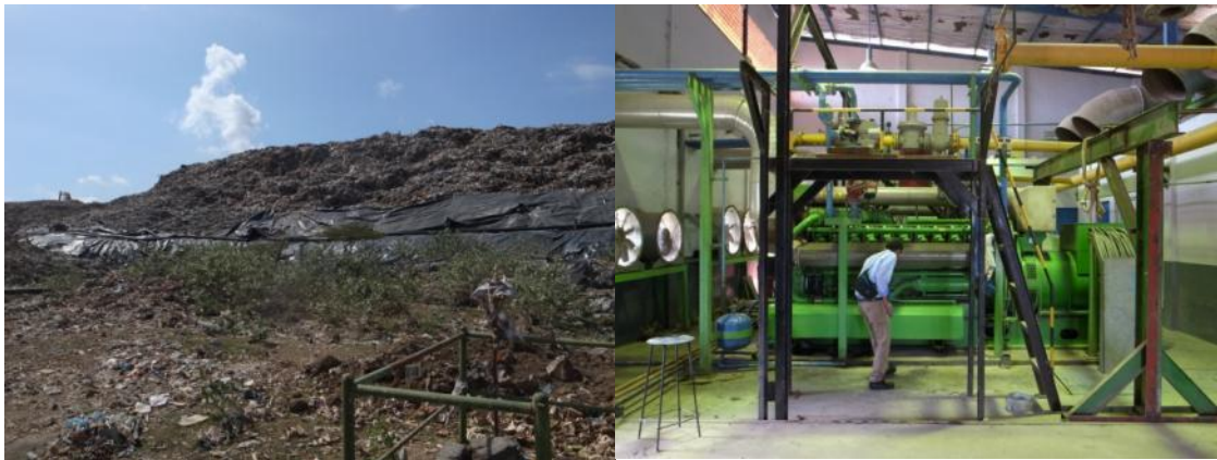
図 19 ランドフィルガスによる発電
