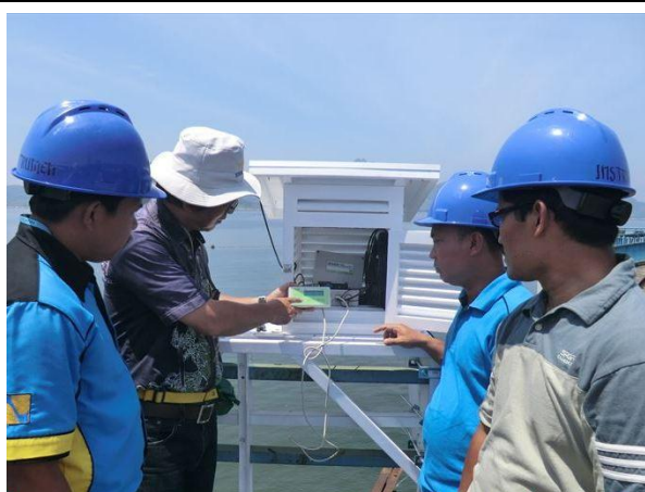
写真5 ジャティールフルダムに設置された SESAME、水中の水位計と接続
