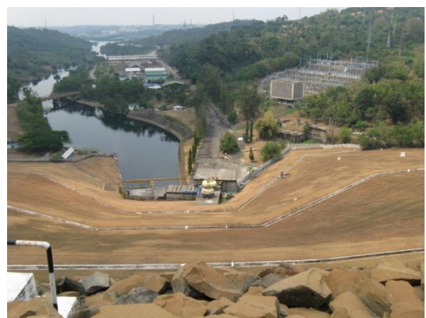
ジャティールダムの多目的用途の一つである発電所
