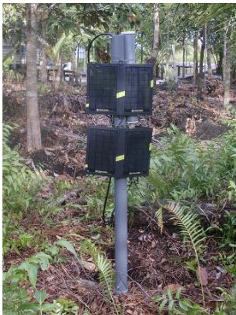
SESAME III システム子機 2枚の黒い太陽光パネ ルの上の筒に納められ、水位計が接続される
