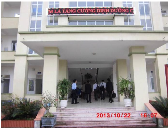
【写真 29 ヘルスセンター入口】
