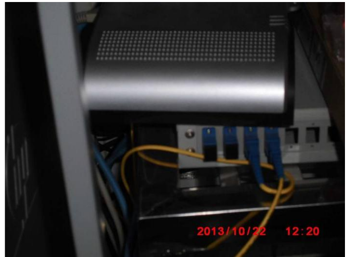
【写真 12 CT 撮影室内の光ケーブル】
