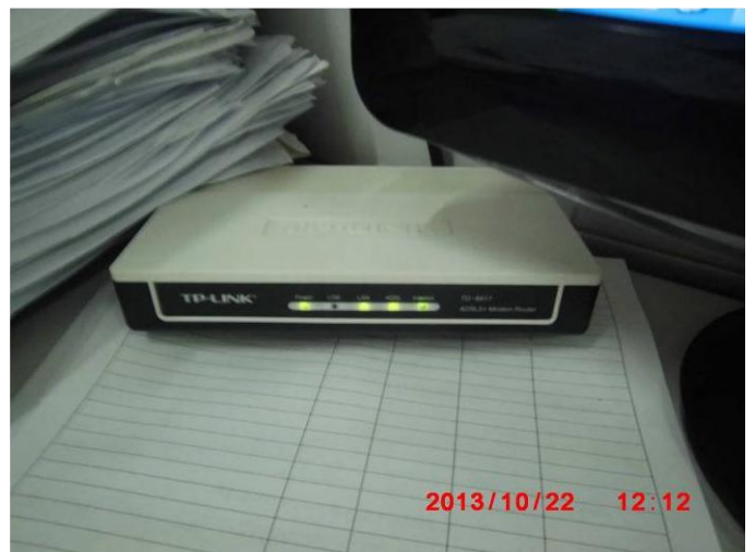
【写真 10 保険窓口内に設置された HUB】
