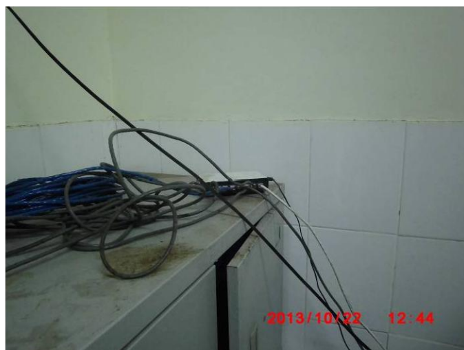
【写真 26 HUB 設置場所】
