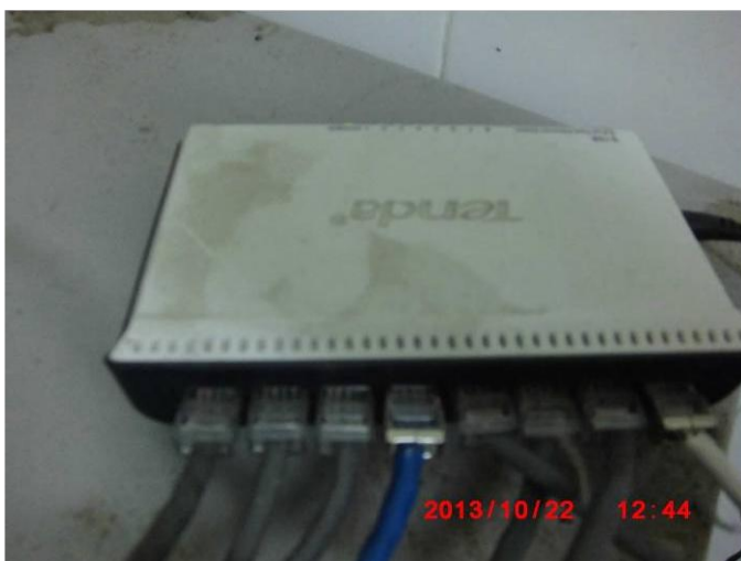
【写真 25 同室設置の HUB】
