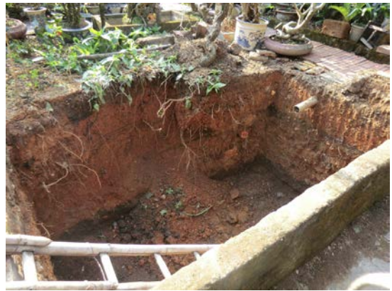
掘削（新浄化システム）
