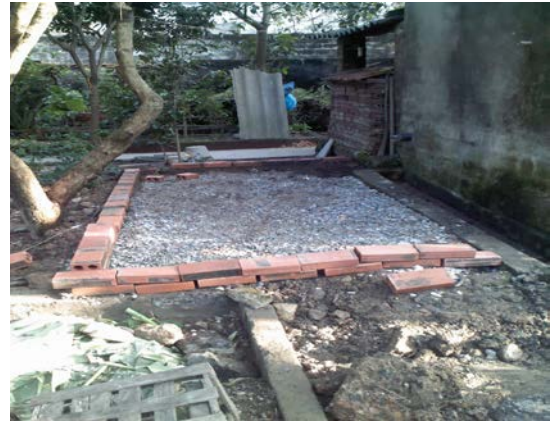
基礎施工 (バイオトイレ)
