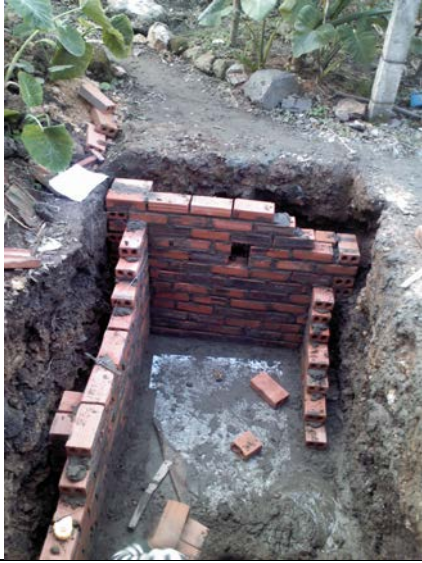
基礎施工（新浄化システム）
