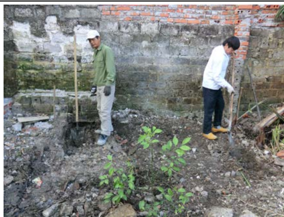
基礎施工 (新浄化システム)
