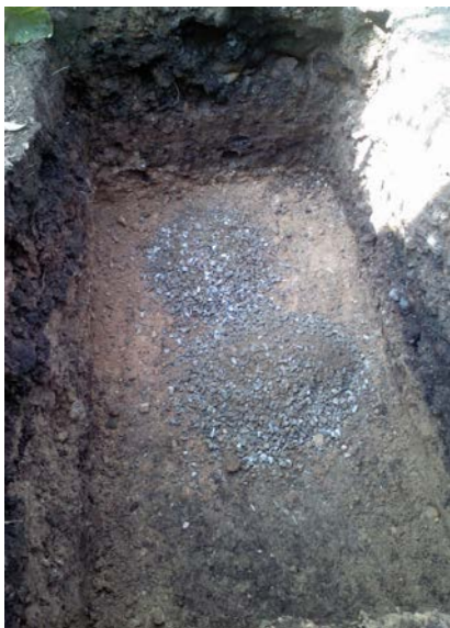
掘削 (新浄化システム)
