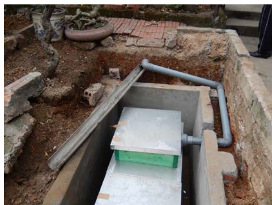
新浄化システム設置作業
