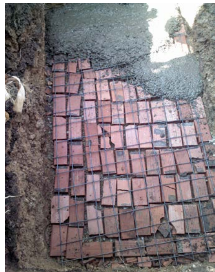
基礎施工 (新浄化システム)
