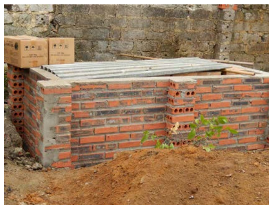
基礎施工 (新浄化システム)
