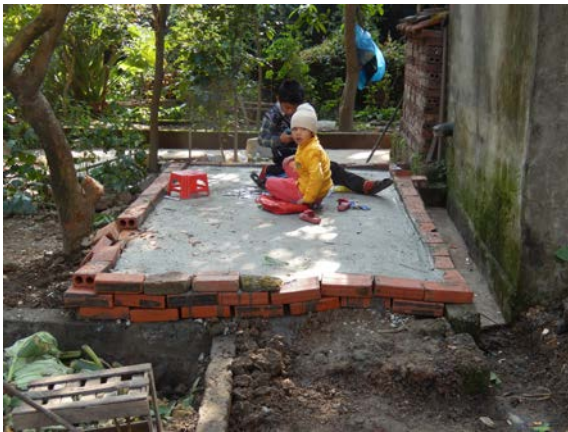
基礎施工 (バイオトイレ)
