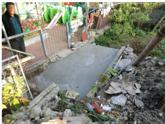
基礎施工 (バイオトイレ)
