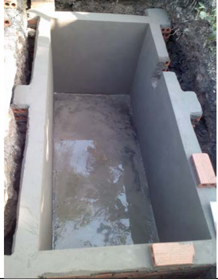
基礎施工（新浄化システム）
