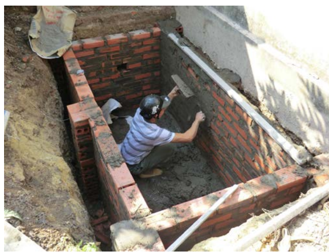
新浄化システム施工状況
