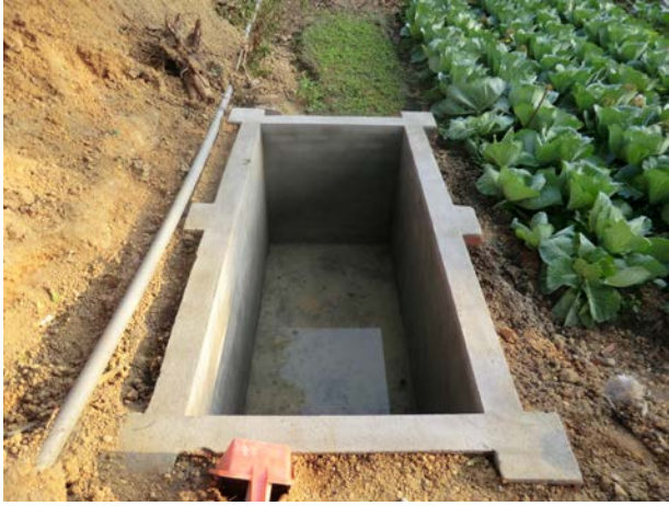
新浄化システム施工状況
