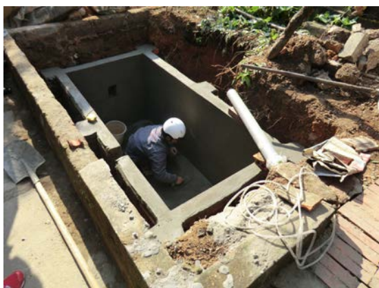
基礎施工（新浄化システム）
