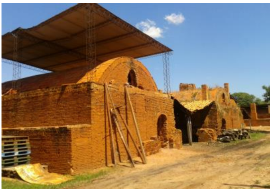
トバティ煉瓦工場
