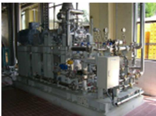
煮沸釜排出蒸気再圧縮再利用システム
