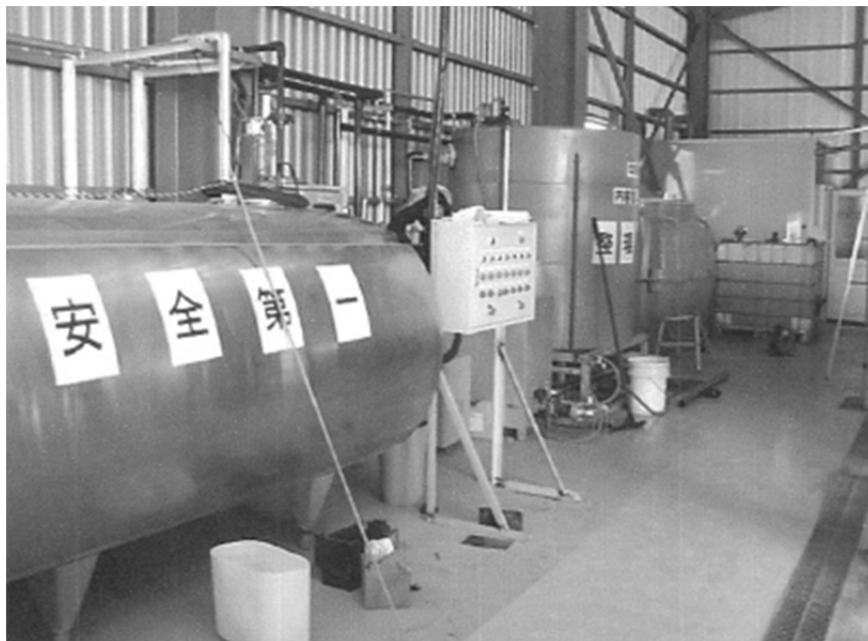
図：希硫酸の中和処理設備 27
