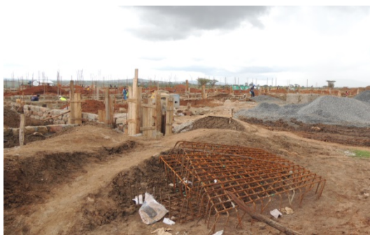
マチャコス新市街地開発現場 (処理施設設置の候補地)
