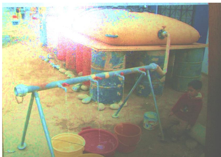
図 1-4：避難所に設置された給水タンク（プーノ）
