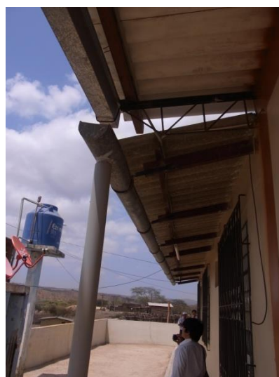
診療所の既設の雨樋 (トゥンベス州カシータス)
