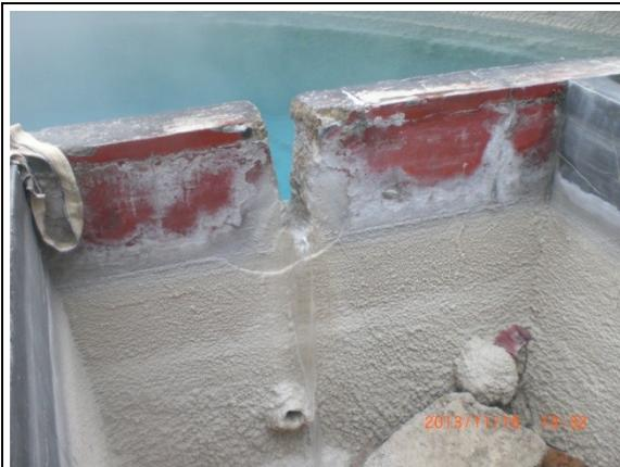
写真 25 源泉貯水槽からのオーバーフローで貯水槽への流入量を実測
