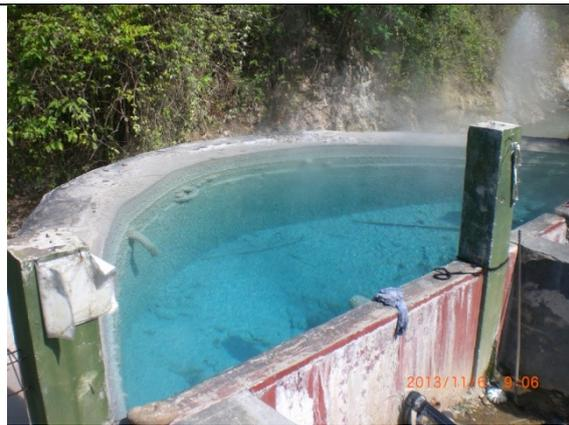
写真 6 熱水貯水槽(温泉プールへ送水)
