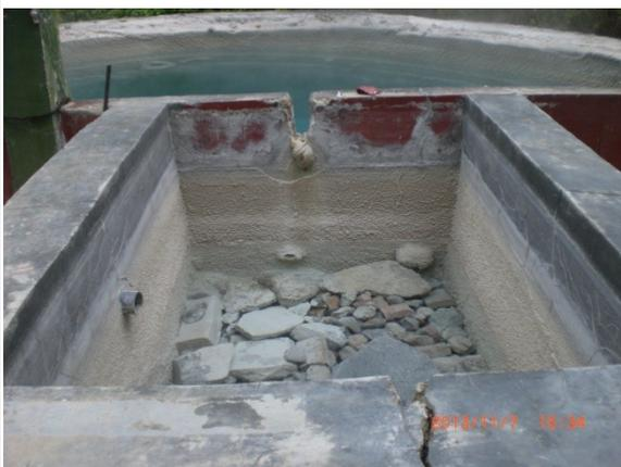
写真 11 貯水槽への流入量をオーバーフローさせて噴出量として計測予定
