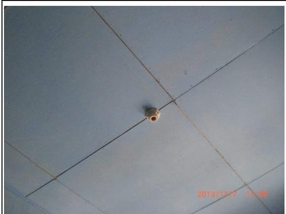
写真 15 電球の外れたソケット(教室)
