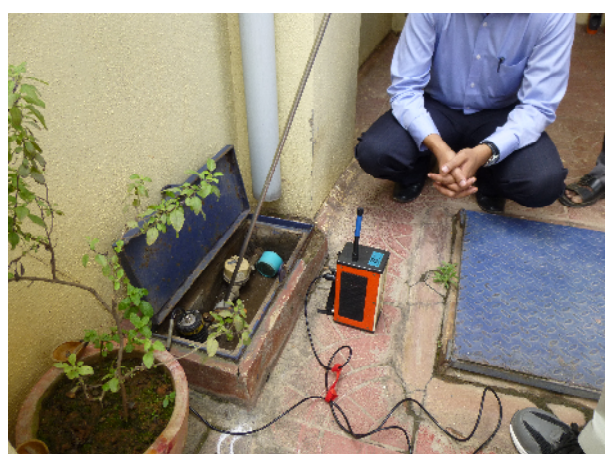
相関式による漏水検知（１）
