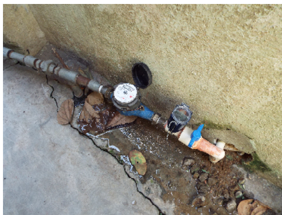
L-sign を用いた漏水箇所のモニタリング
