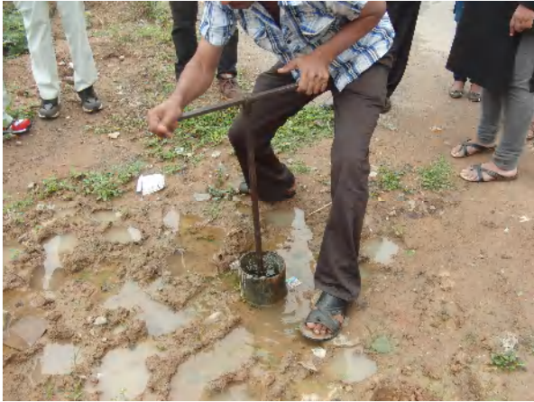
給水ラインマンによる給水バルブの開閉
