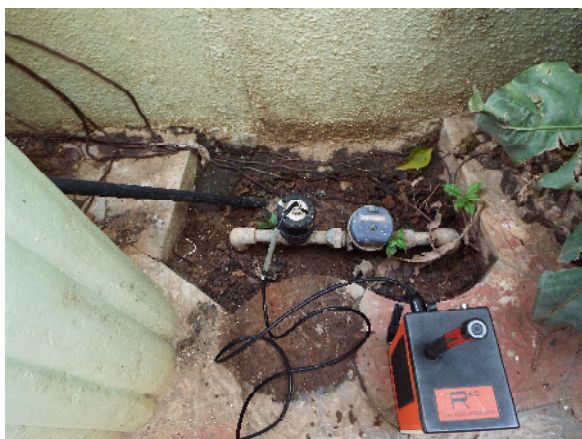
相関式による漏水検知（２）
