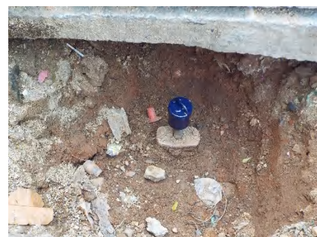
図 3 - 1 1 仕切弁の状況と配水管用 L-sign 設置状況
