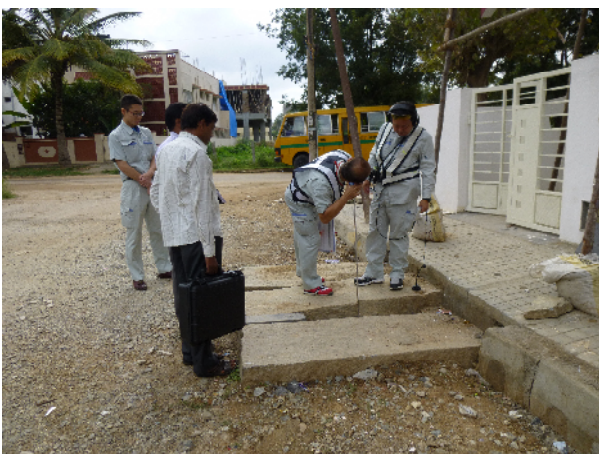
音聴式による漏水検知（２）
