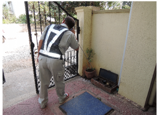
音聴式による漏水検知（１）
