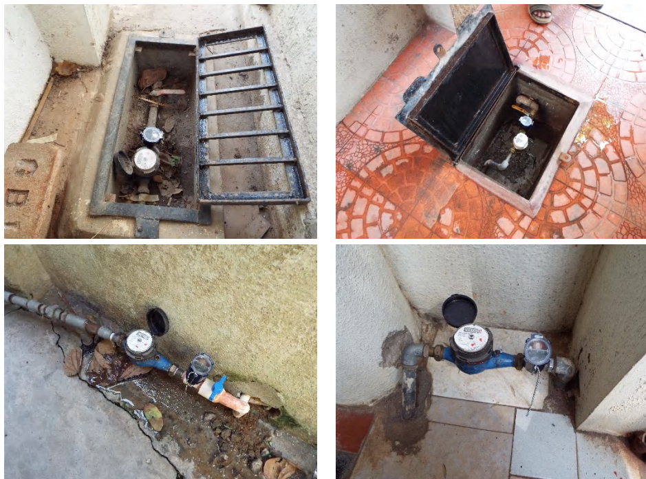
図 3 - 1 2 給水管用 L-sign 設置状況
