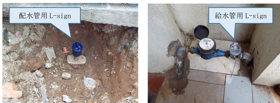
図 3-3 常設型自動漏水検知器（L-sign）設置状況図
