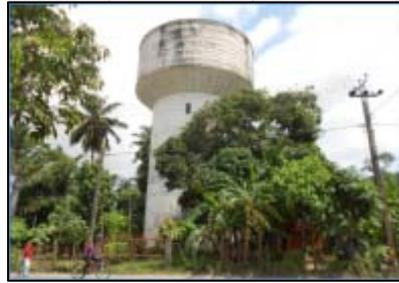
写真 2 RC 貯水池を PC 鋼材で補強（マータラ県ガバダーウィーディヤ）
