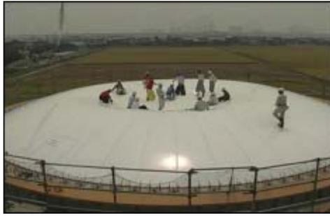
写真 7 エアードーム工法による施工例
