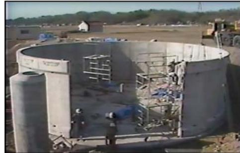
写真 8 コンクリート PC パネルによる施工例
