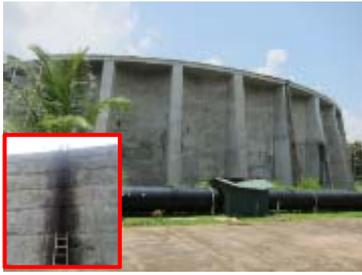
写真 1 大型 RC 貯水池を控え壁で補強（ガンパハ県チャーチヒル）
