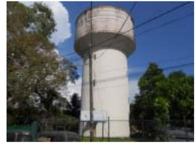
写真 3 RC 貯水池を PC 鋼材で補強（マータラ県ヌーペ）
