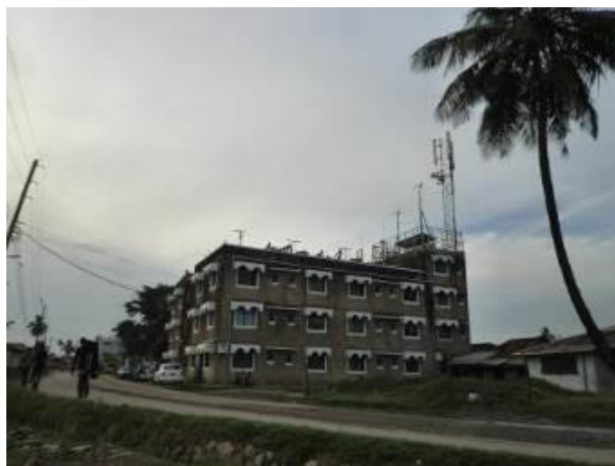
モンバササイト（建物外観）
