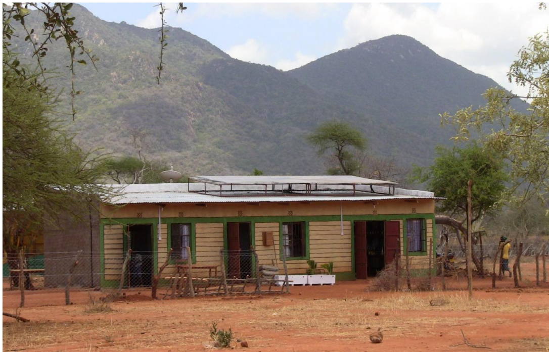
太陽光トランジションプロジェクトのエネルギーセンター
