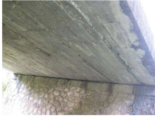
写真 3-2-6 床版橋 (No. 21 Lang Lai)
