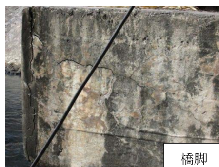
写真 3-2-21 下部工のひび割れ (No. 1 Cầu Mai Động)
