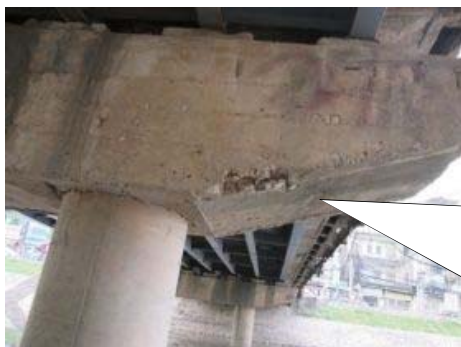
写真 3-2-20 下部工の鉄筋露出 (No. 9 Cầu Khương Đình)
