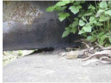
写真 1-2-1 鋼桁の腐食（左、右ともに Na Quan 橋）
