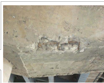
写真 3-2-20 下部工の鉄筋露出 (No. 9 Cầu Khương Đình)
