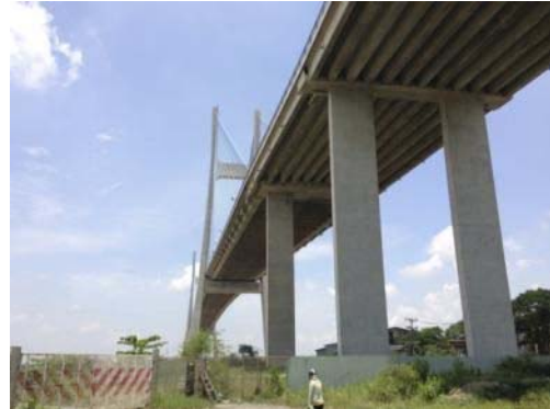
(ホーチミン市内の大規模橋梁)
