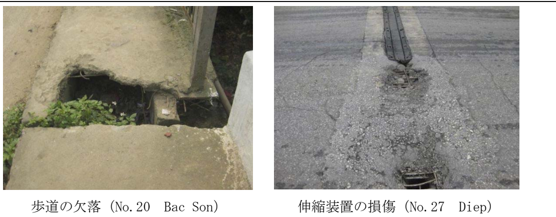
図 3-2-44 損傷写真 (その他)
