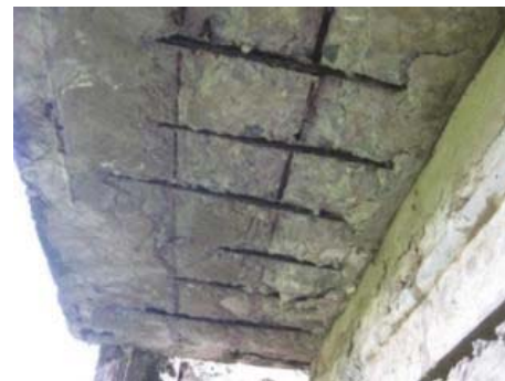
写真 1-2-2 コンクリート橋の床版の鉄筋露出（左：Yen Bien 橋、右：Lang Cha 橋）
