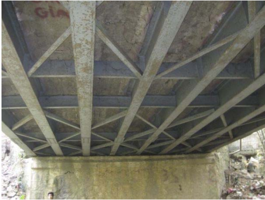
写真 3-2-11 鋼桁橋 (No20 Bac Son)
