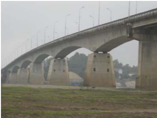
写真 3-2-9 ラーメン橋 (No. 38 Trung Ha)
