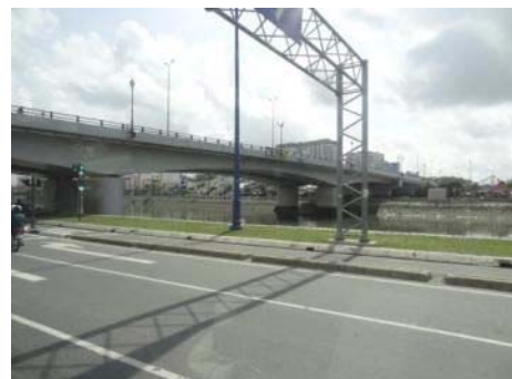
(ホーチミン市内の橋梁)
