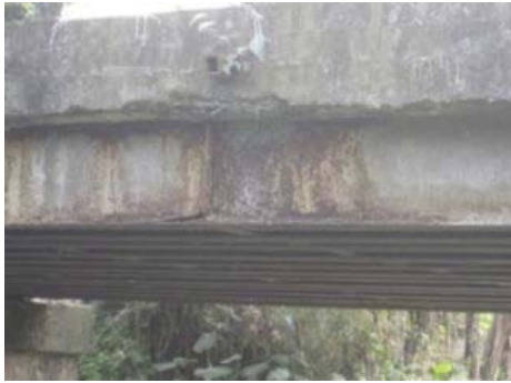
写真 1-2-1 鋼桁の腐食（左、右ともに Na Quan 橋）
