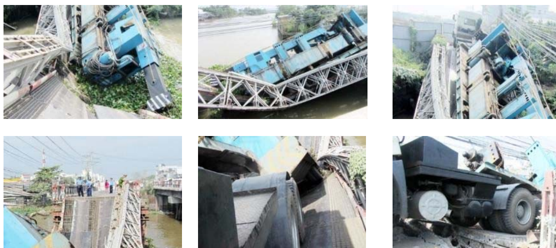
写真1-2-4 過積載車両による落橋事故（VNExpress）
