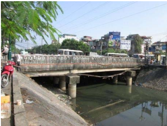
ハノイ市内の橋梁
