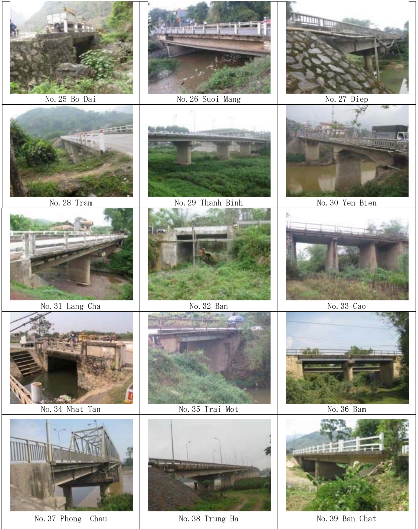
图 3-2-37 解析对象桥梁 (VBMS、40 桥)-3
