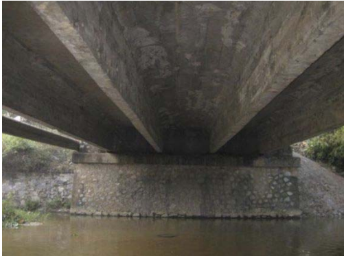
写真 3-2-5 T桁形式 (No. 26 Suoi Mang)
