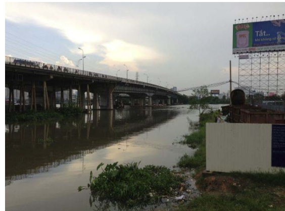
ホーチミン市内の橋梁
