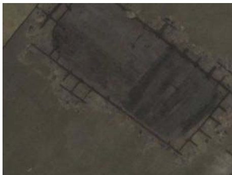
写真 1-2-2 コンクリート橋の床版の鉄筋露出（左：Yen Bien 橋、右：Lang Cha 橋）
