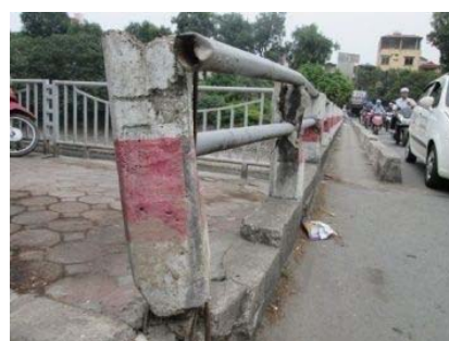
写真 3-2-24 防護柵の破損 (No. 11 Cầu 361)
