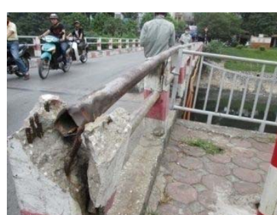
写真 3-2-24 防護柵の破損 (No. 11 Cầu 361)
