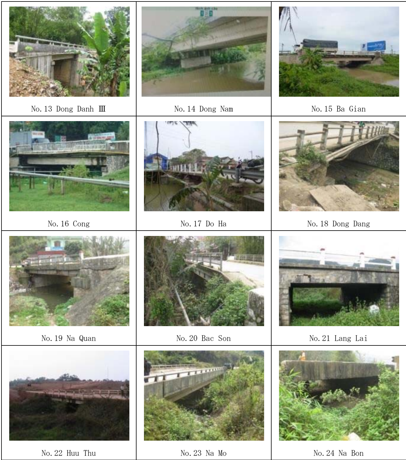
图 3-2-36 解析对象桥梁 (VBMS、40 桥)-2
