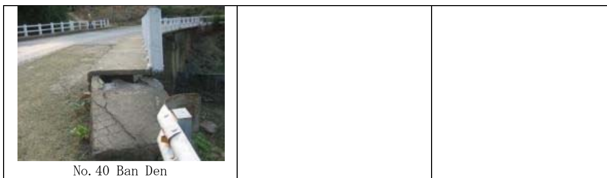
図 3-2-38 解析対象橋梁 (VBMS、40 橋)-4
