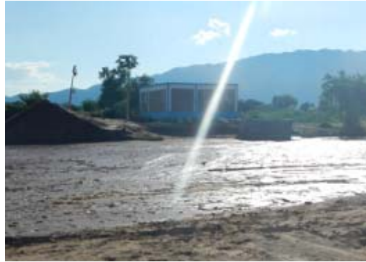
図 1-26 イタリア政府の支援で建設中のポンプ場
