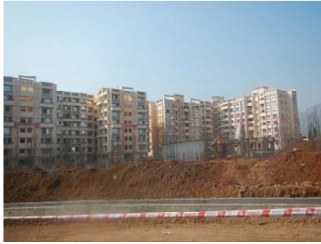
図 1-20 Badlapur 市内のアパート建設ラッシュの状況
