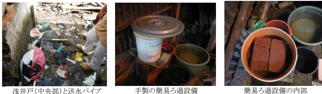
図 1-10 Red Zone 地区の手掘り井戸と手製の簡易ろ過設備
