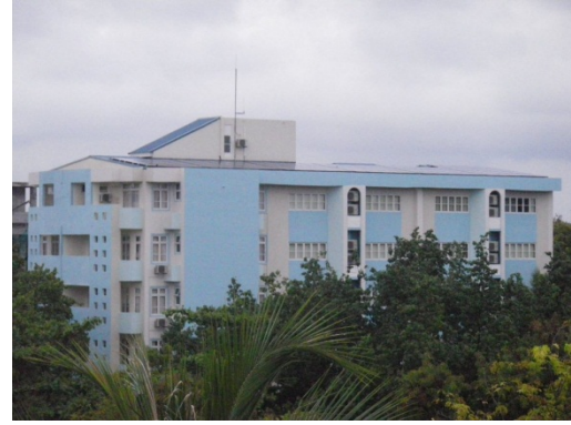
(f) 司法省屋根の PV パネル
