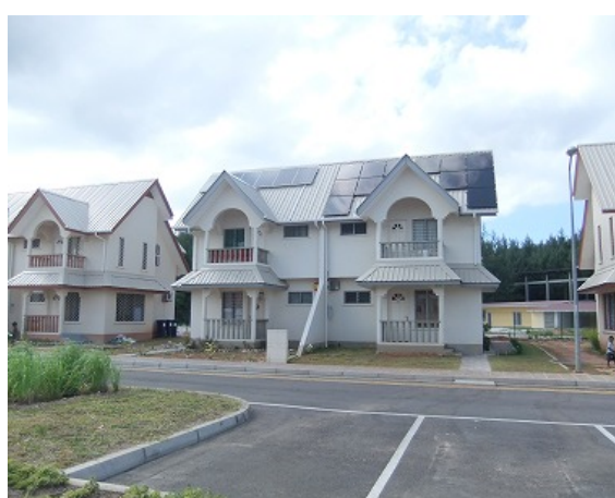
系統連系型太陽光発電システム調査
