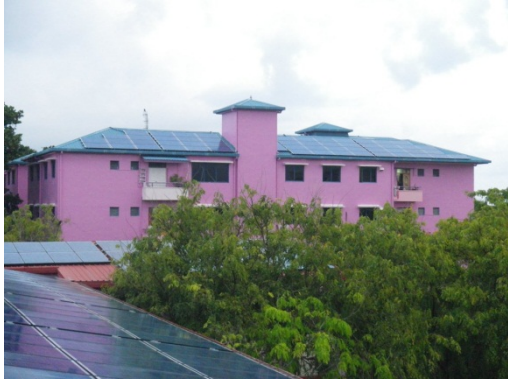
(e) 建物屋根の PV パネル
