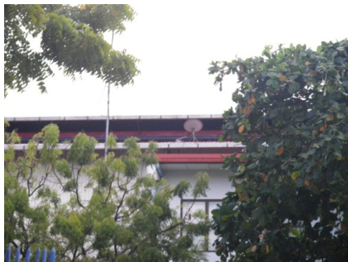
(a) 発電所屋根の PV パネル
