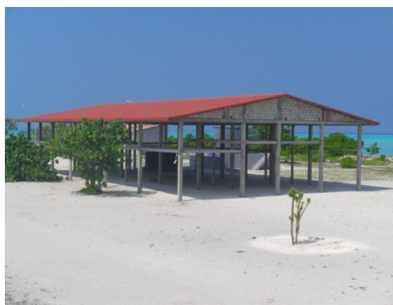
Gaafaru 島新発電所 (建設中)
