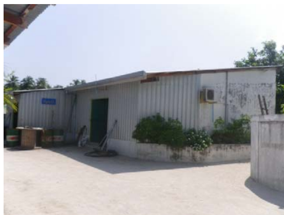
図 3-2-3.4 Gaafaru 島の現発電所
