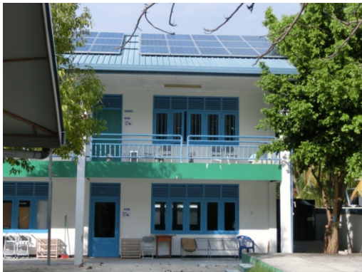
(e) 学校屋根の PV パネル
