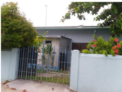
(a) 発電所屋根の PV パネル
