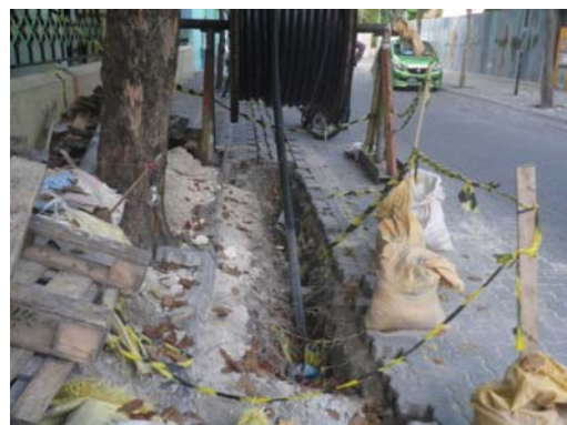
図 3-2-1.3 地中線工事状況
