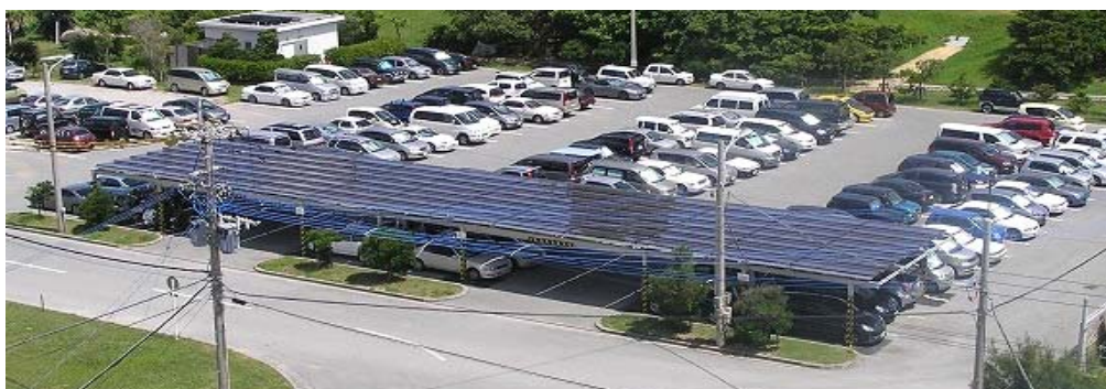
図 3-1-2. 8 カーポートタイプの PV システム
