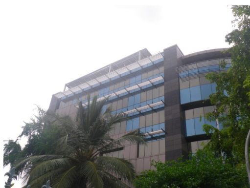
(a) STELCO Office 屋上の PV システム
