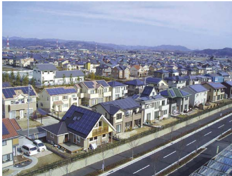
図 1-2-3.1 切妻屋根及び寄棟屋根に設置された PV システム（群馬県太田市）
