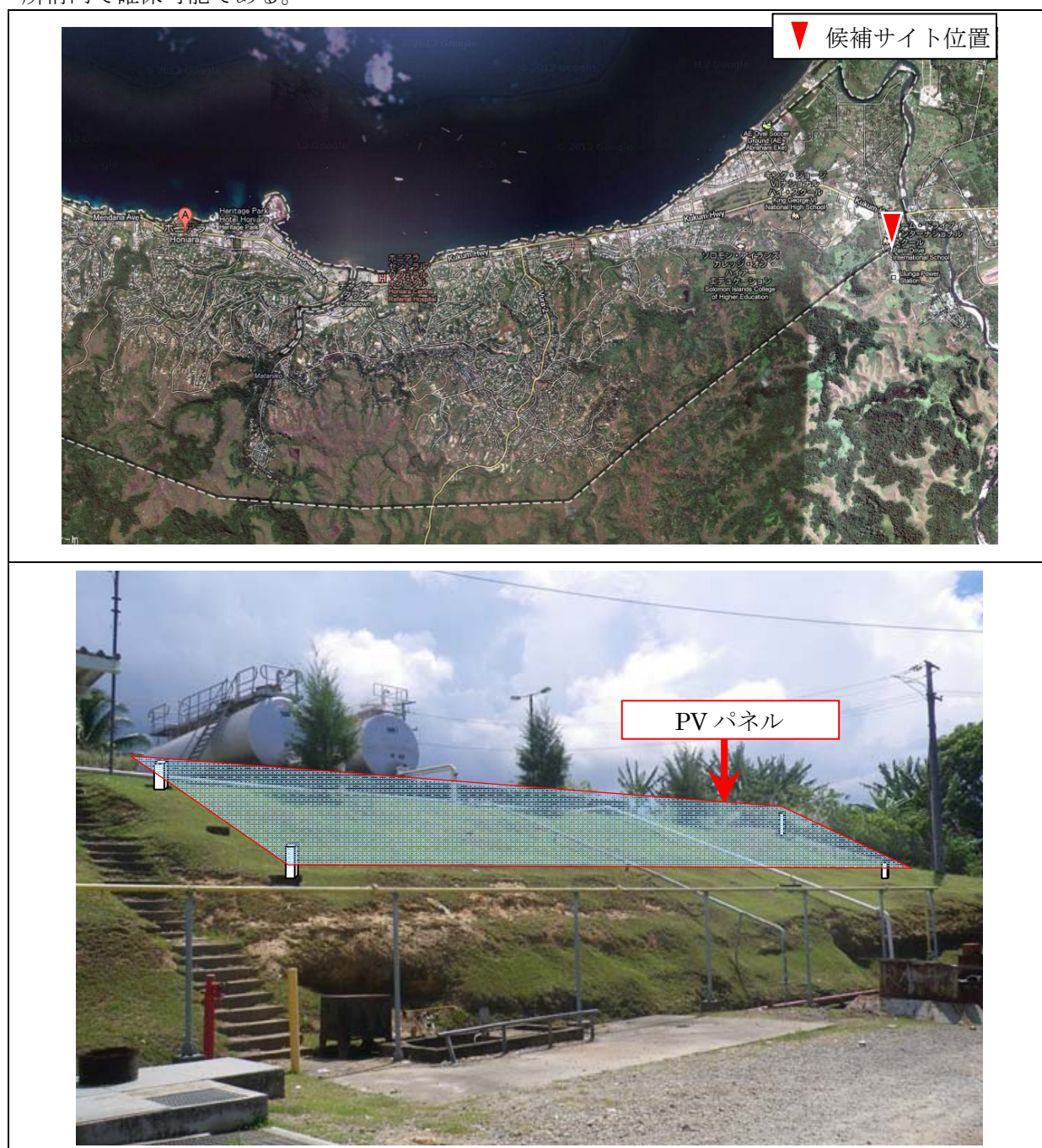
図 2-2-2. 5 PV パネル 設置イメージ(ルンガ発電所 敷地内)
