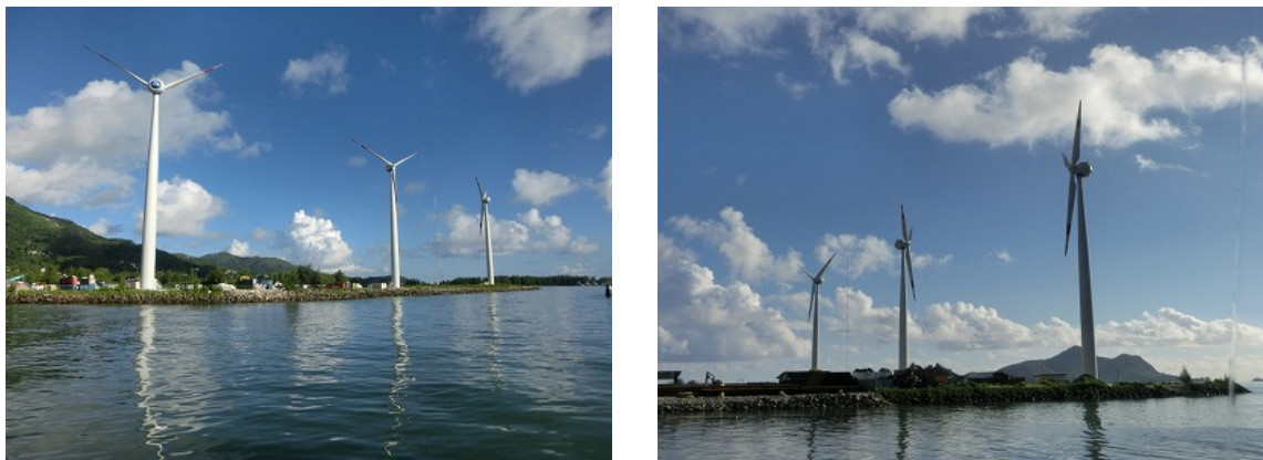
図4-3-1.1 マヘ島に導入が進められている風車
