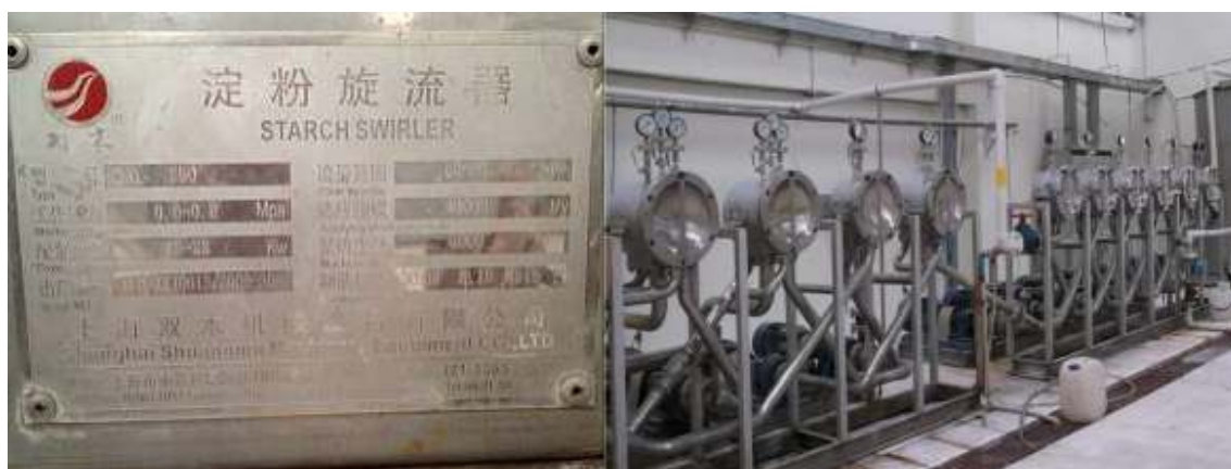
写真：KPN Tapioca Factory で用いられている遠心分離機（ハイドロサイクロン方式）
