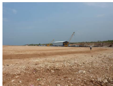
図 I-5 PT.DAYA RADAR 造船所建設中/建造も開始中
