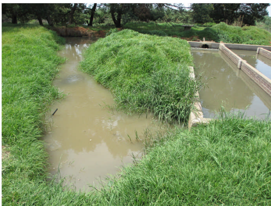
図 1－1－1 2 処理能力を超えた流入量による不十分な処理水の放流
