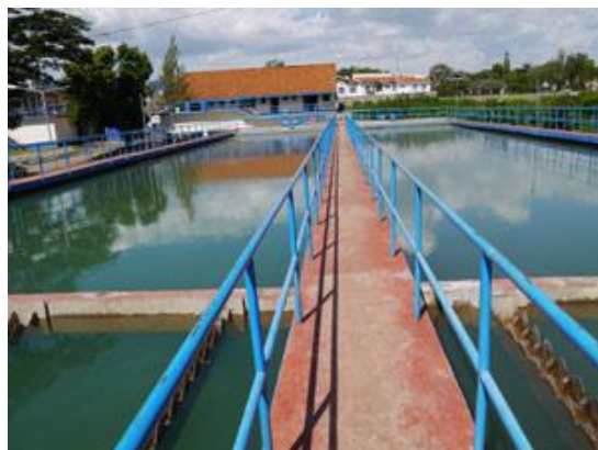
④ フロックの沈殿槽
