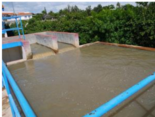
② 薬品（高分子凝集剤）を投入
