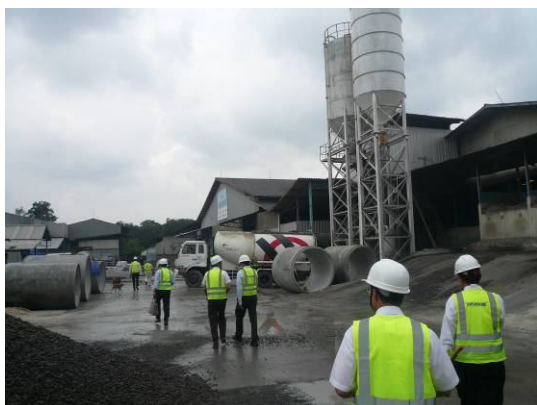
コンクリート製品工場視察（２）
