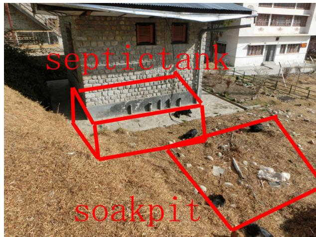
**土壤浄化法の技術・沈殿分離槽**
