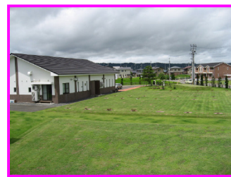
坂下東浄化センター
