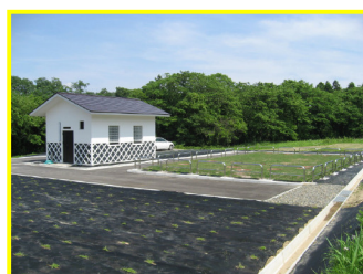
長井浄化センター
