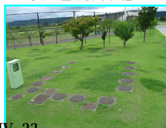
鶴沼公園合併浄化槽
