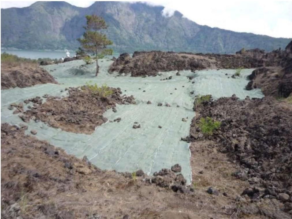
写真D 多機能フィルター・シート敷設完了風景 A 地区 (2012年12月17日)
