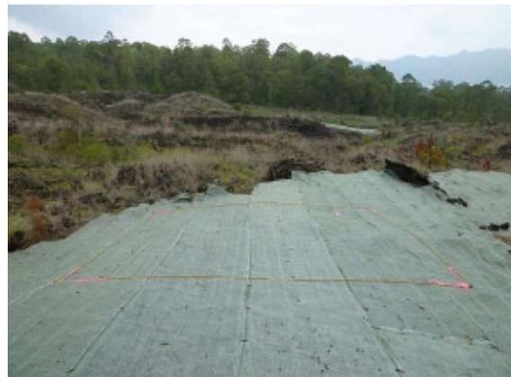
写真-3-1-1-8 A 区-4 種子散布+シート敷設施工状況（左）及び全景（右）
