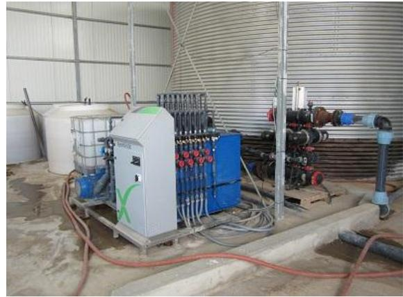
地下水の塩分濃度が高いため、逆浸透膜での脱塩を施して使用している
