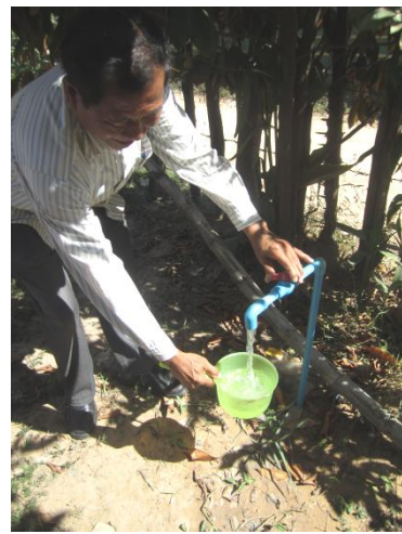
設置された水道蛇口
