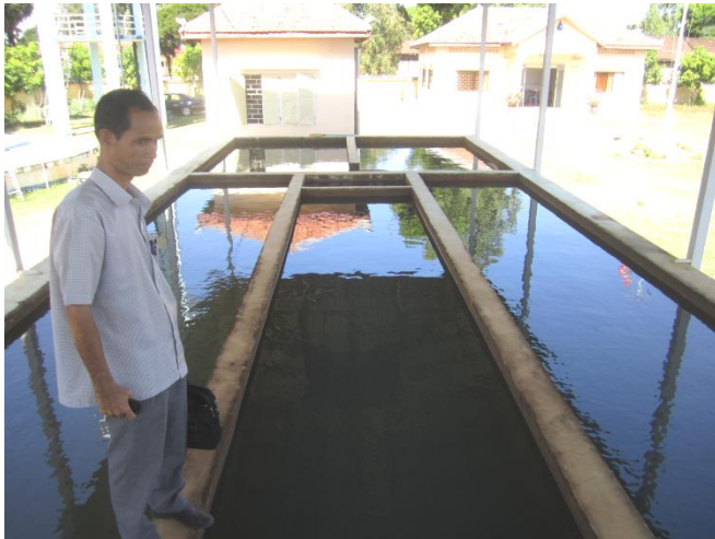
タンクラサン水道局浄水施設
