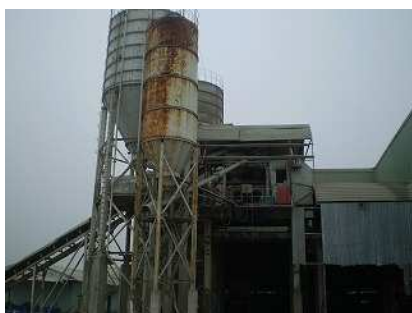
強制2軸ミキサーによるミキサープラント
