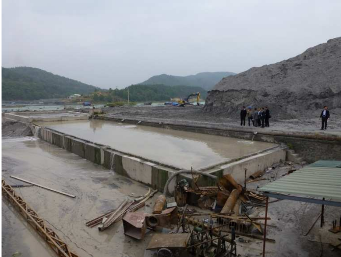
改質灰の沈降池
