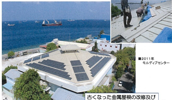
古くなった金属屋根の改修及び太陽光パネル設置
