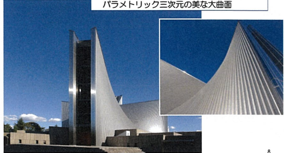
■東京カテドラル聖マリア大聖堂・外壁改修工事
