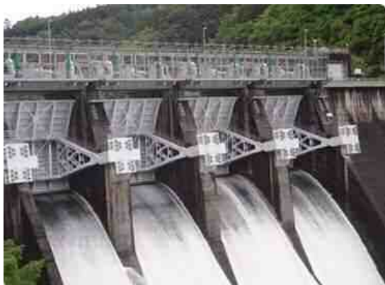
ダム・河川用水門
