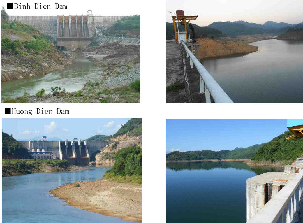
図 1.6.2.3 対象ダムの外観 (2012. 12. 16 撮影)
