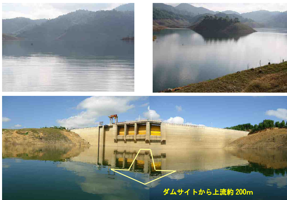
図 1.6.3.4 Binh Dien ダム 調査地点 (B1) の状況
