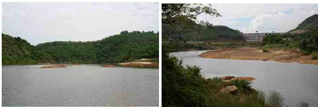
図 1.6.3.12 Huong Dien ダム直下流地点（H-2）の状況
