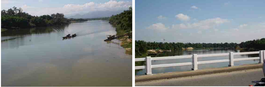
図 1.6.3.13 Bo 川調査地点 (H-3) の状況
