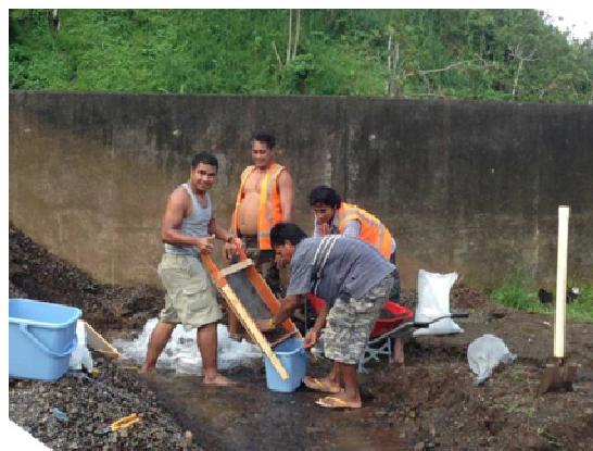
写真 2-1-30 砂洗浄、篩分け作業
