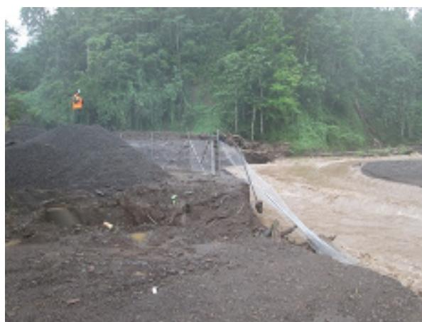
写真 1-2-13 崩壊したフェンス
