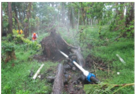
写真 1-2-9 既設管路の空気抜き
