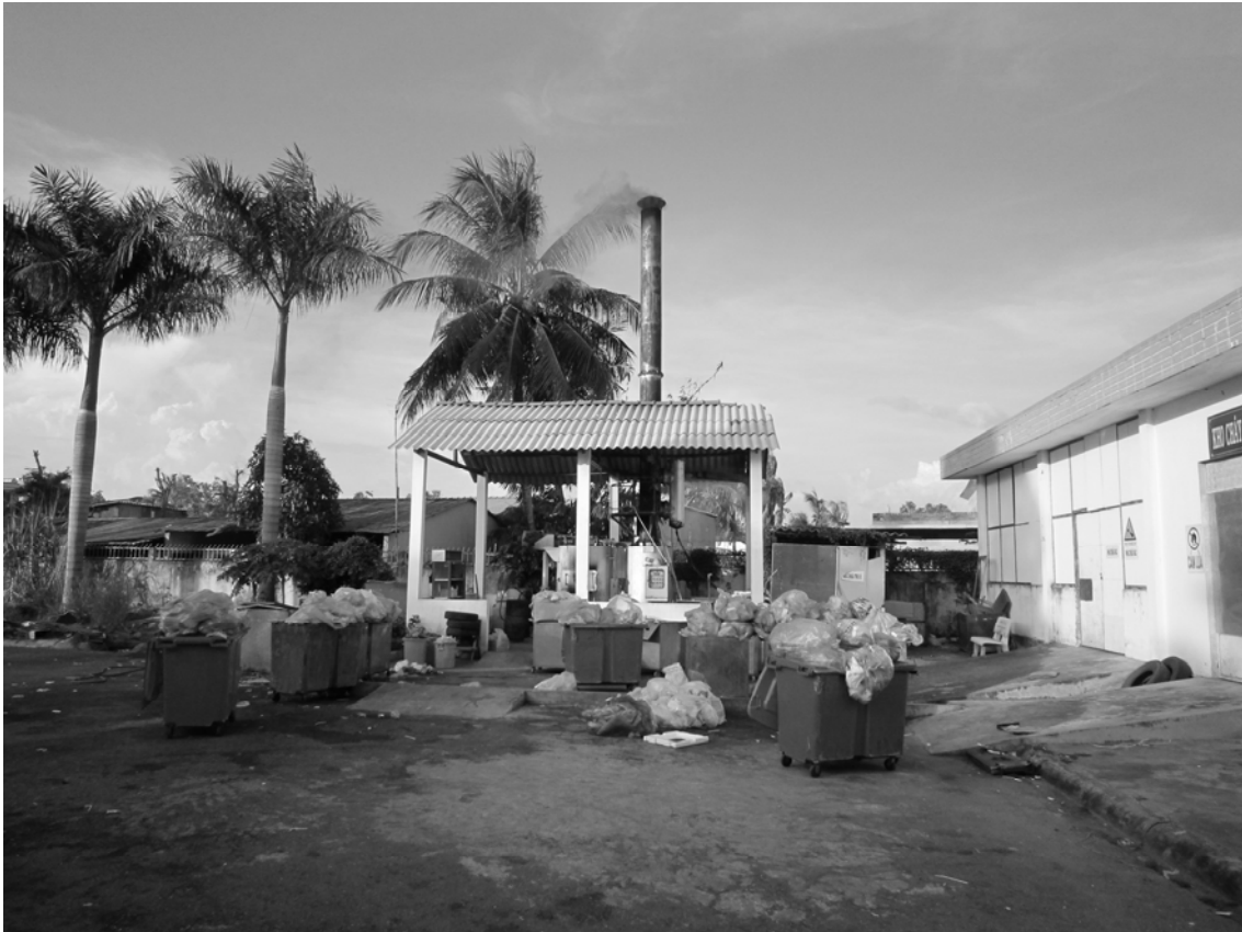
ロンアン省医療機関内に設置された焼却炉
