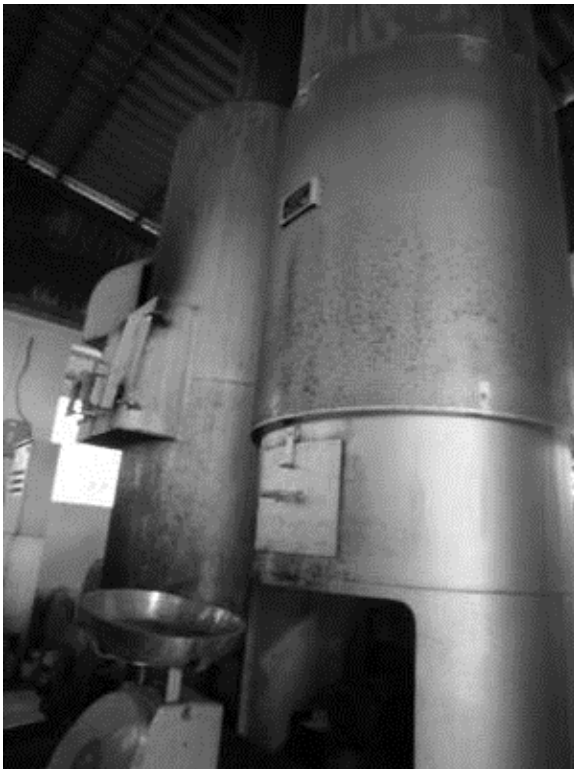
図 2.3 ベトナム国で使用されている焼却炉 出所：著者撮影
