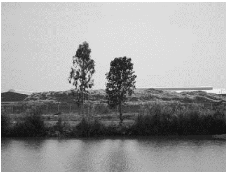
図 1.15 ビンロン省の一般廃棄物の埋立て処理場 出所：当社撮影（同省への移動中に撮影）
