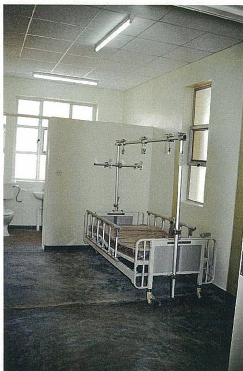
⑧女性病棟1ベッド室
