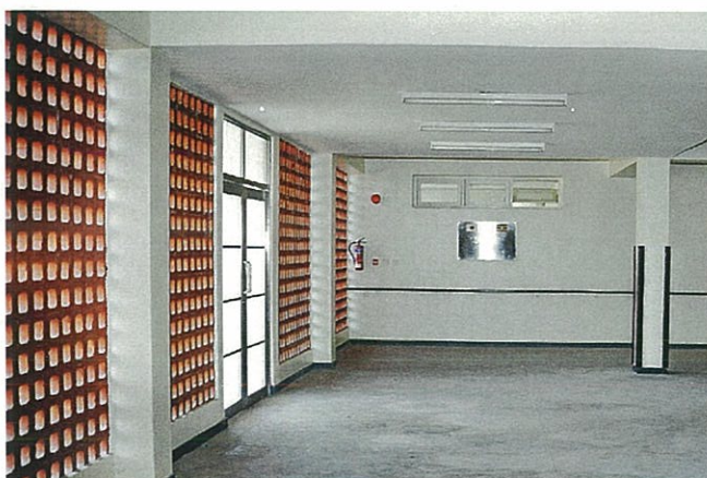
⑨外来棟銘板設置箇所
