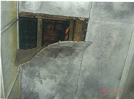
手術室天井：天井が雨漏りにより剥がれている。衛生的な環境が保てない状況である。
