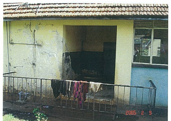
産科棟外観：設備の漏水、塗装の劣化が目立つ。
