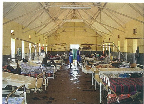
男性病棟:劣化が進んでいるが、トラスが鋼製であり、女性病棟よりは程度が軽い。
