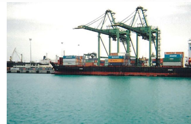
④ インド：ツチコリン港浚渫事業。日本の有償資金協力で浚渫された港内泊地。写真提供：JICA
