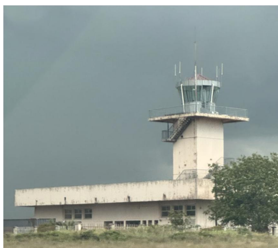
①ダルエスサラーム空港 管制塔
