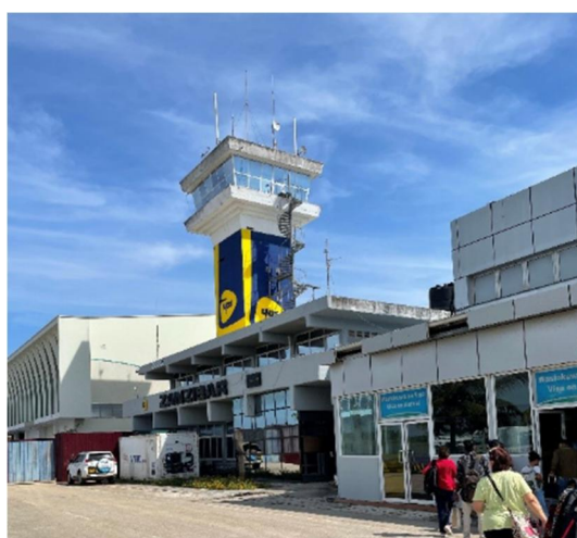
③ザンジバル空港 管制塔
